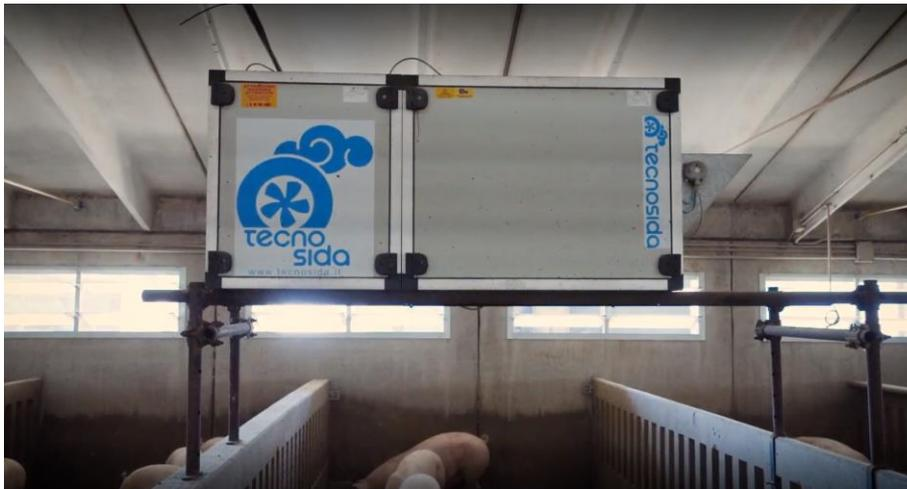
Figura 5. Sistema di filtraggio a secco installato nell'allevamento italiano di suini
